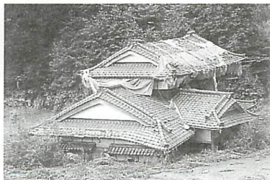
木籠地区の被災状況
